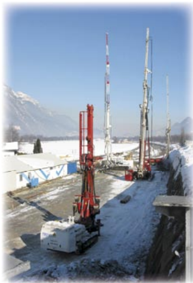
Der zukünftige Trassenverlauf von Tunnel und Wanne ist Richtung Jenbach schon gut zu erkennen.
